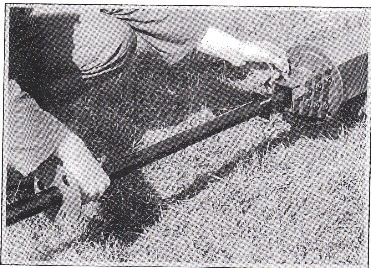
Figur 213: Montering af topleddet på teleskopmasten.
