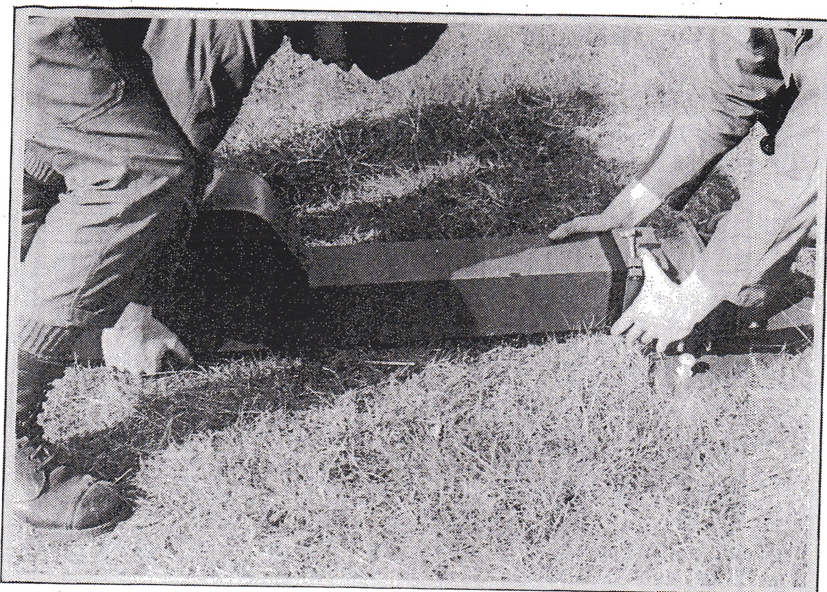
Figur 211: Teleskopmast og mastefod samles og fastspændes.
