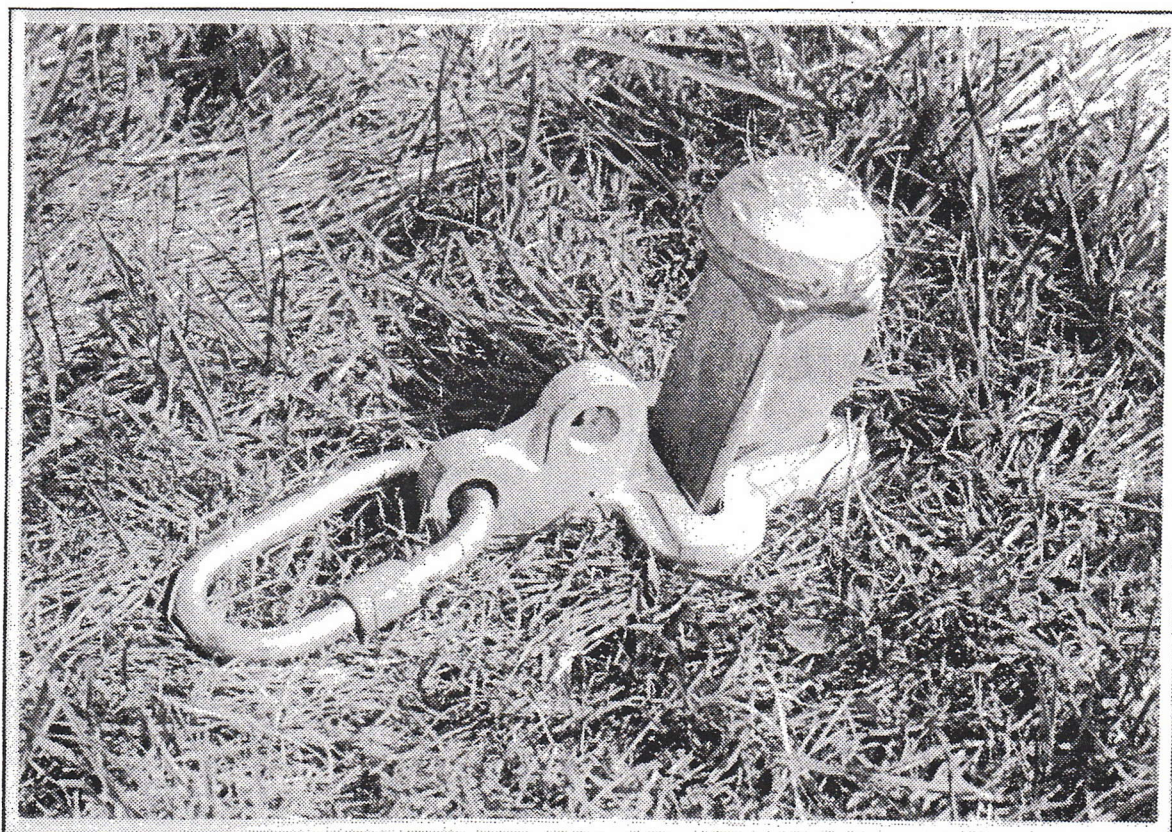
Figur 210: Nedramning af pløkke for barduner.
